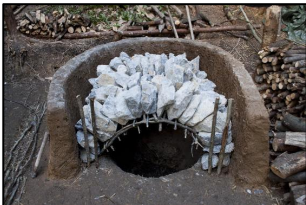
Ukázka skladby vsázky kusového vápence v peci (příprava experimentálního výpalu na Slovensku)
